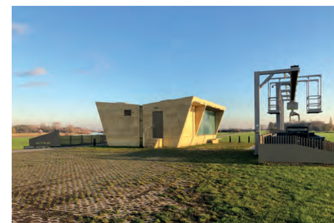
gemaal Laag Helbergen - Cortenoever
